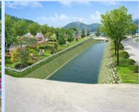
<성포경관정비 및 쉼터조성 후>
