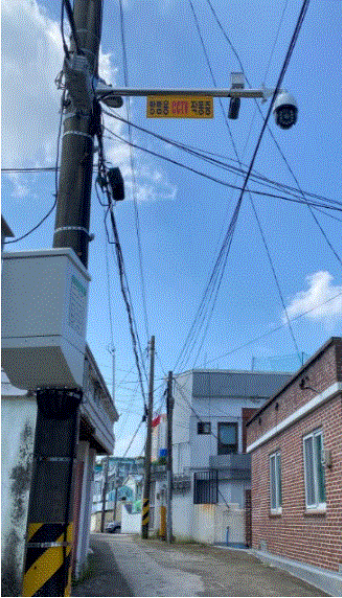
골목길 내 CCTV 설치
